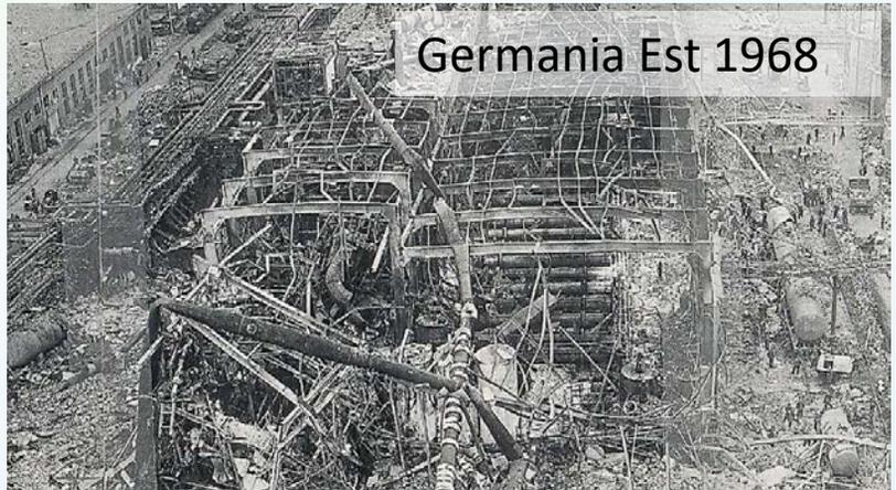
La pressione del reattore è stata abbassata scaricando il gas da una valvola di sicurezza nel capannone di produzione, provocando una grande esplosione con 42 morti e centinaia di feriti tra i dipendenti. Gli altri 11 reattori e i cilindri di stoccaggio del cloruro di vinile sono fortunatamente rimasti integri.
